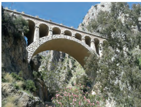
Wiadukt linii kolejowej
