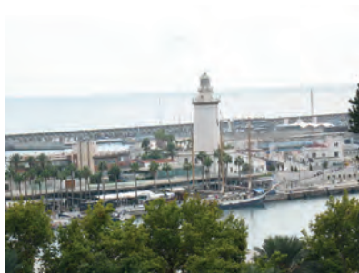
Latarnia morska w porcie Malagi
