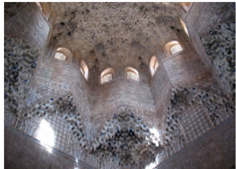
Sklepienie Sali Abenceragów
